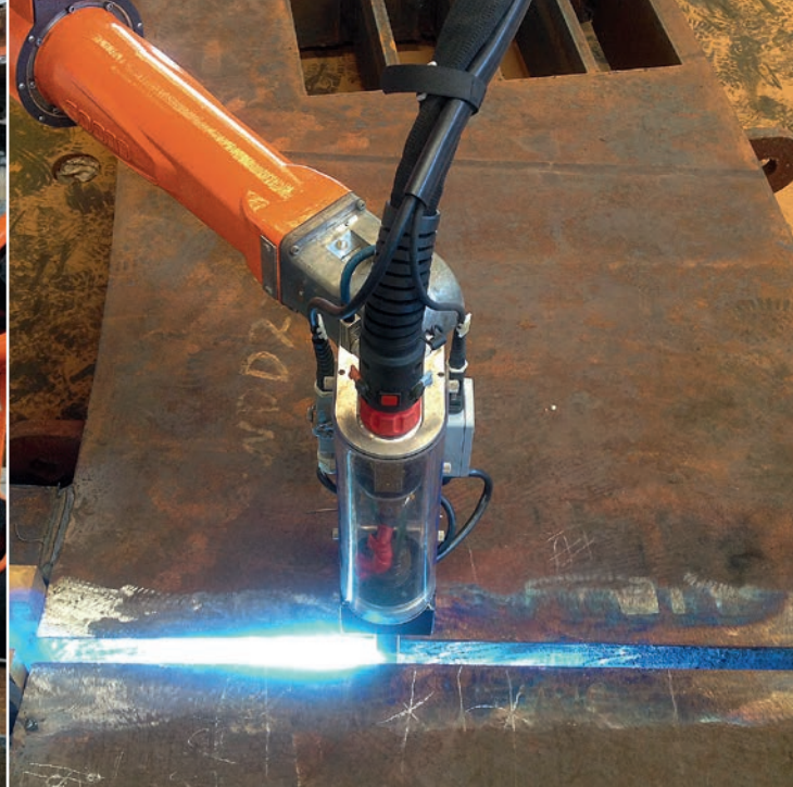
Engspaltschweißen im Voith Hydro-Werk in Shanghai
