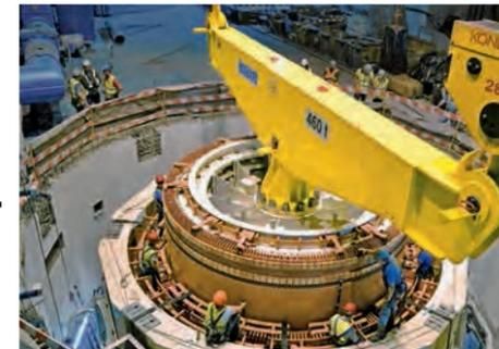
Frades II 水电站正在安装一台异步发电电动机组
