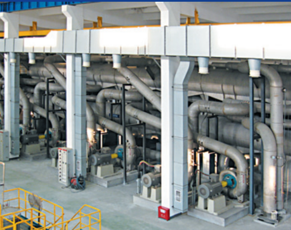
EcoCell Flotationsanlage.
