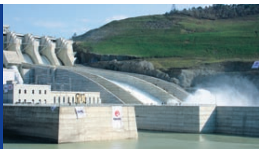
Borçka水力发电厂在土耳其北部的Çoruh河上
