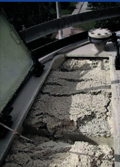
反应器上部的堰板堵塞了
