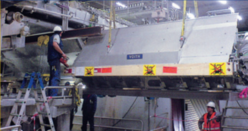
Taustakerroksen perälaatikon asennus oli todellinen haaste
