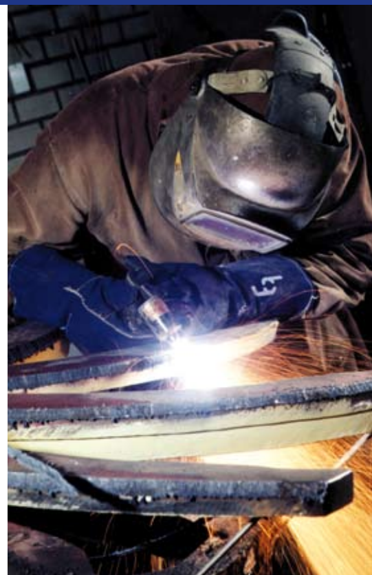
Spezielle Kenntnisse von Schweißtechnologie und Material sind notwendig, um den Rotor in seiner Originalgeometrie wiederherzustellen.
