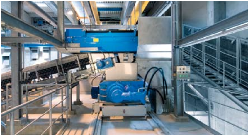
Zerkleinerung und Metallabscheidung sind die Voraussetzung für die Verbrennung der hochkalorischen Spuckstoffe.
