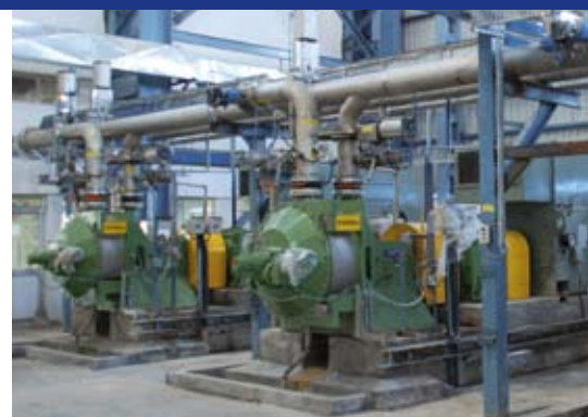
Die Stoffaufbereitung umfasst die beiden Aufbereitungslinien für Kurz- und Langfaser.
