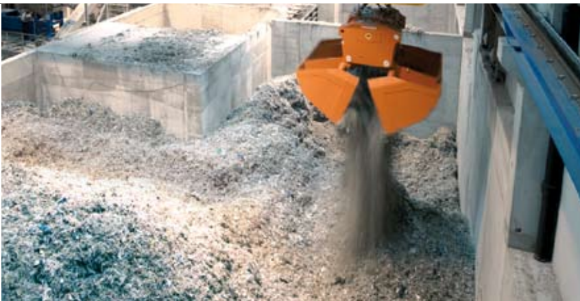
Ein intelligentes, selbst fahrendes Kransystem holt Brennstoff aus dem Bunker und beschickt die sekundären Behandlungsstufen, Misch- und Zuführsysteme.
