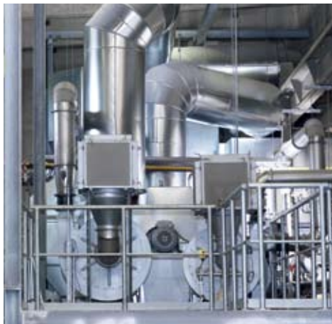
MCB-Dryer 干燥器的通风装置
