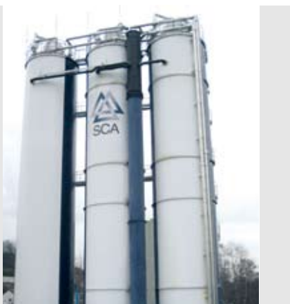
德国 SCA 公司旗下阿沙芬堡纸厂经过改造的反应器（中间那个）
