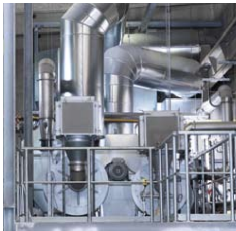
Lufttechnik zum MCB-Dryer.
