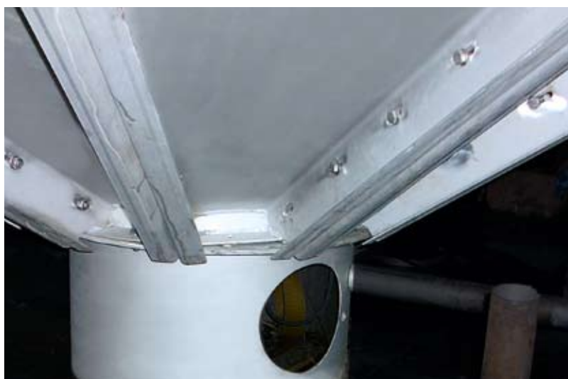
Segmentierter konusförmiger Reaktorboden.
