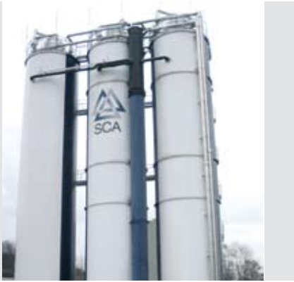
Der umgerüstete Reaktor bei SCA Aschaffenburg (Mitte).
