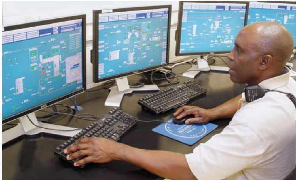
Blick in die Warte: Die Visualisierung des Prozessleitsystems für die Deinkinganlage.
