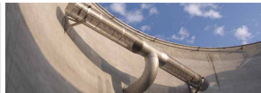
Устройство для удержания субстрата реакторов MBBR..
