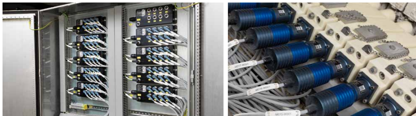
Блоки электроуправления установлены отдельно, в защищенных шкафах.
