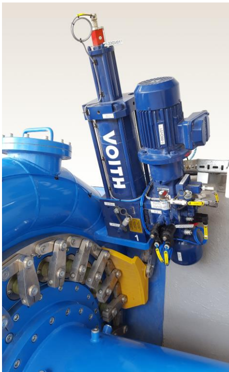
Bildunterschrift 2: Der neuartige Turbinenregler steuert den Wasserdurchfluss in der Anlage durch das Verstellen der Turbinenschaufeln.
