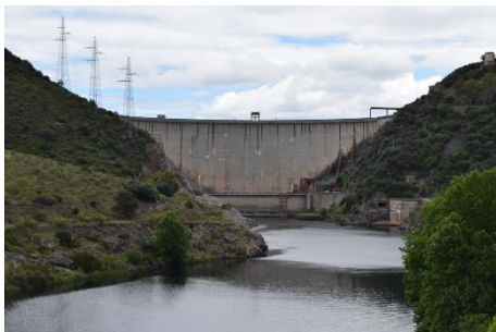
Das Wasserkraftwerk Valdecañas wird mit drei Deriaz-Pumpturbinen mit einer Leistung von jeweils 83 MW ausgestattet.
