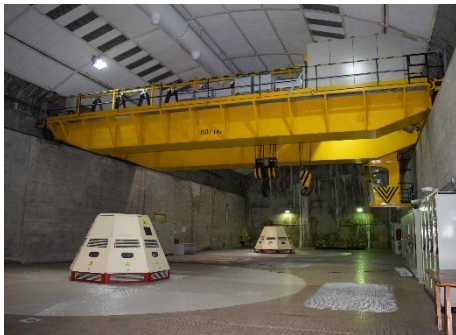
Das Wasserkraftwerk Torrejón wird mit zwei halbaxialen Pumpturbinen mit einer Leistung von jeweils 43 MW ausgestattet.
