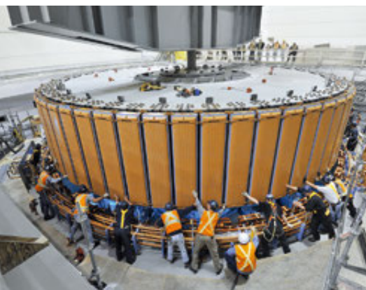
Beeindruckende Dimensionen – der neue Rotor der Unit 5 des Kraftwerks Revelstoke wird eingefahren.
