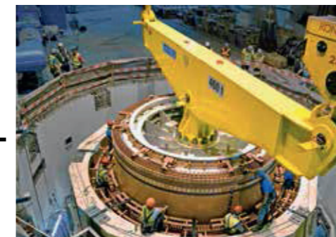
L'un des groupes moteur-alternateur asynchrone en cours d'installation à Frades II.
