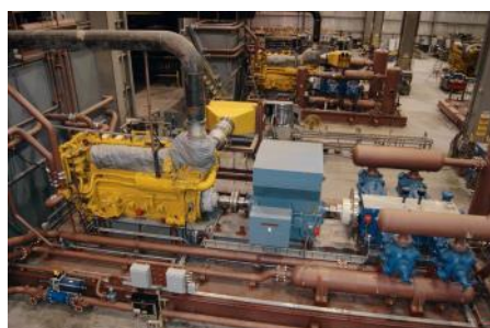
Kompressoranlagen in den USA, ausgestattet mit hochelastischen Kupplungen und HyGrip Verbindungskupplungen von Voith
