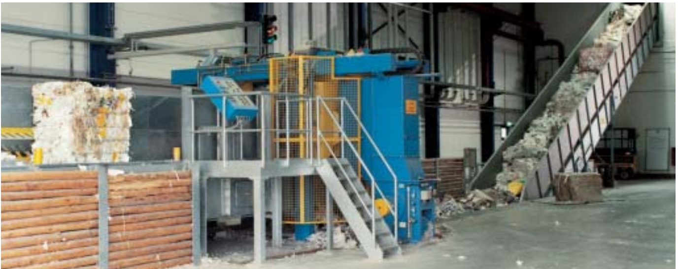
Abb. 2: Die Förderanlage mit Altpapier-Ballen- Entdrahtung, geplant und gebaut von der B+G Fördertechnik GmbH, Euskirchen im Unternehmen der Voith Sulzer Papiertechnik.
